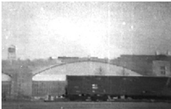
Hangar 18, pode ver-se o vagão de comboio.
